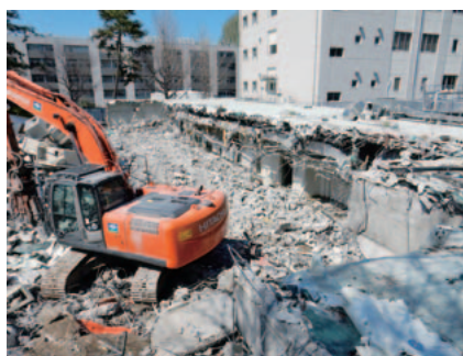
写真2 解体される旧館
