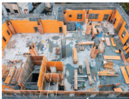
写真3 RI実験棟建設(2階壁構築中)
