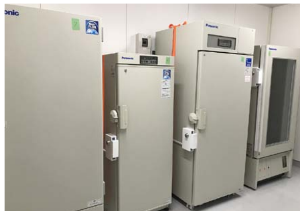
写真9 貯蔵室内の電気錠付冷凍庫・冷蔵庫
