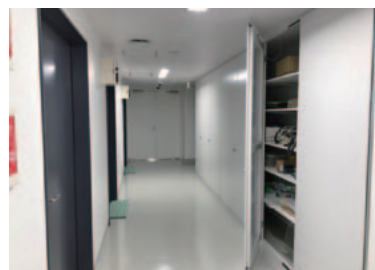
写真5 管理区域内廊下の壁面収納
