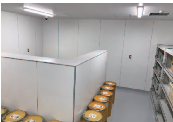
写真12 保管廃棄室内の遮蔽壁
